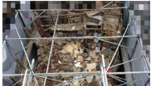
空家代執行(解体)
