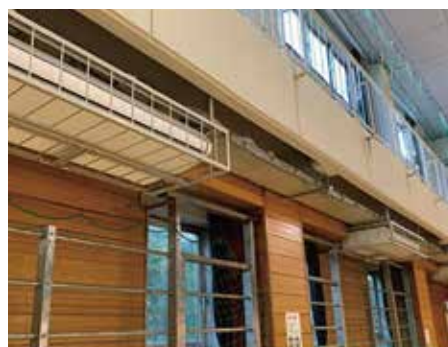
体育館に設置されたエアコン
